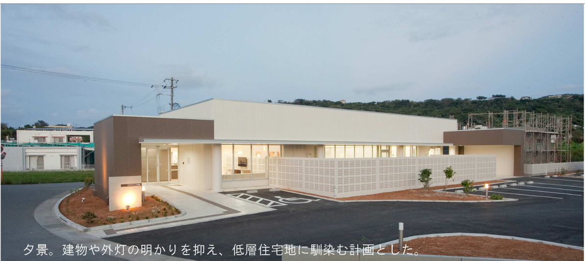
建物を長手方向へ貫く庇は、待合室、リハビリ室、デイケア室へ連続する開口への直射日光を遮る役割を担う。
