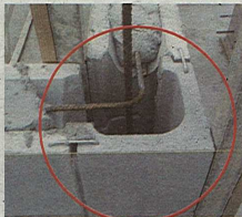
上と右の写真赤丸部が補強コンクリートブロックL型。下がT型。型枠と構造体を兼ねる(写真提供/大城ブロック工業)
