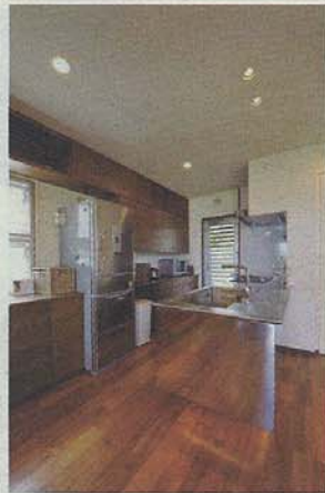
床下18cmの位置にコンクリートを張り出して造った浮遊感のあるキッチン。映り込む材質のステンレスで覆って、より軽やかなイメージに
