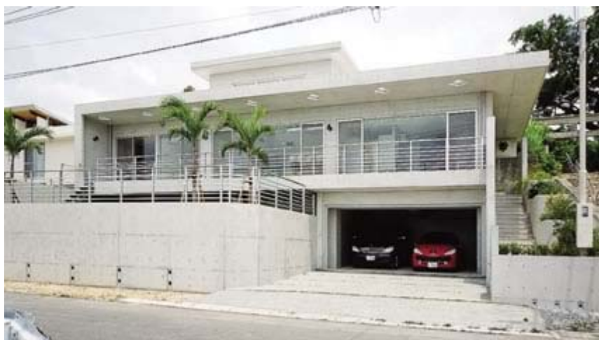
打ち放しでシンプルに仕上げた外観。傾斜した地形に沿って、地階は駐車場に充てた
