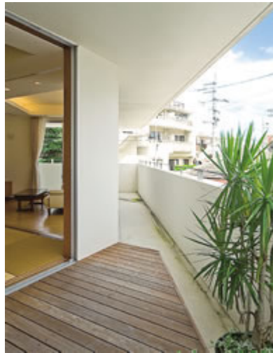
和室に隣接するデッキ。奥には、周辺の繁華街の風景を目隠しする腰壁があるベランダが続く。庇(ひさし)が深いので、来客が多い時には、和室の延長としても使いやすくなっている
