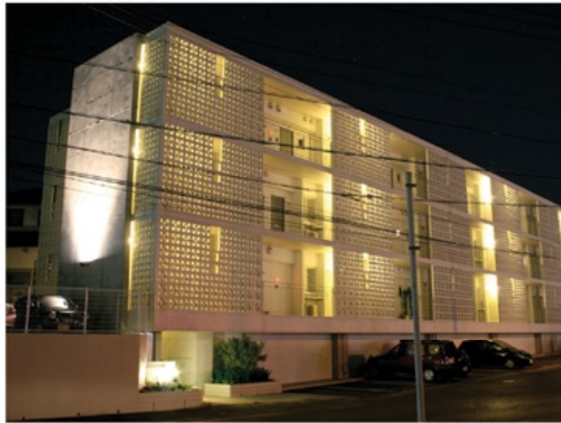
集合住宅廊下部分への導入例
