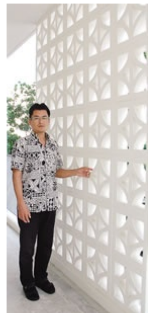
「風を通し緩やかに目隠しする花ブロックは、バルコニーをより使いやすくします」と伊良波氏=那覇市真地の集合住
