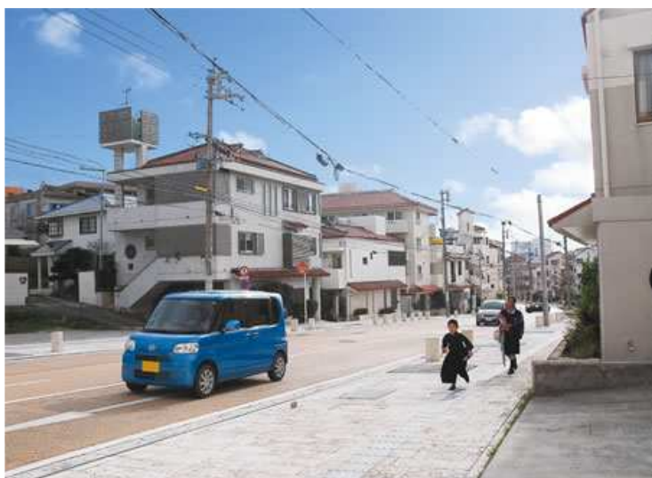
龍潭通り。歩道は琉球石灰岩を布張りにし、車止めも金属ではなく琉球石灰岩を用いている。素材や張り方などは行政と相談、調整を重ねた
