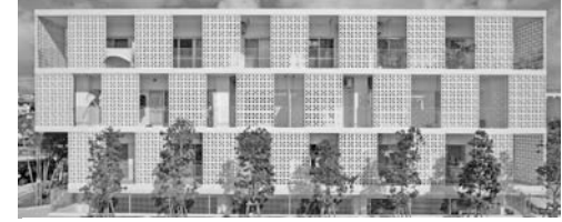
花ブロックを配したスクリーンの様子
